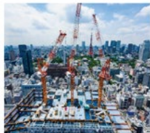
現場作業のシミュレーション
