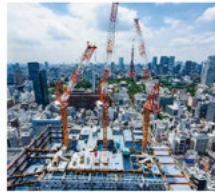
現場作業のシミュレーション
